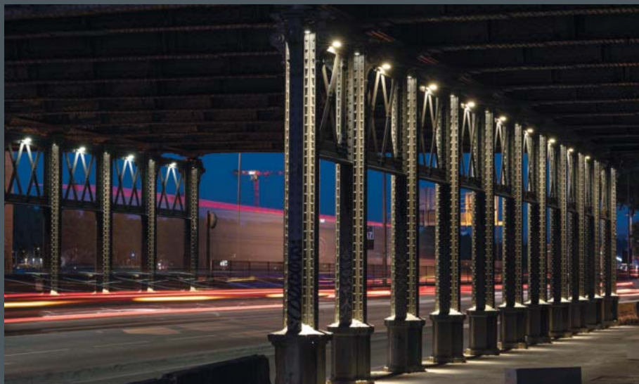
Viaduc SNCF Lyon Perrache Lighting design: Direction de l'Éclairage Urbain de la Ville de Lyon Photo: Michel Djaoui
